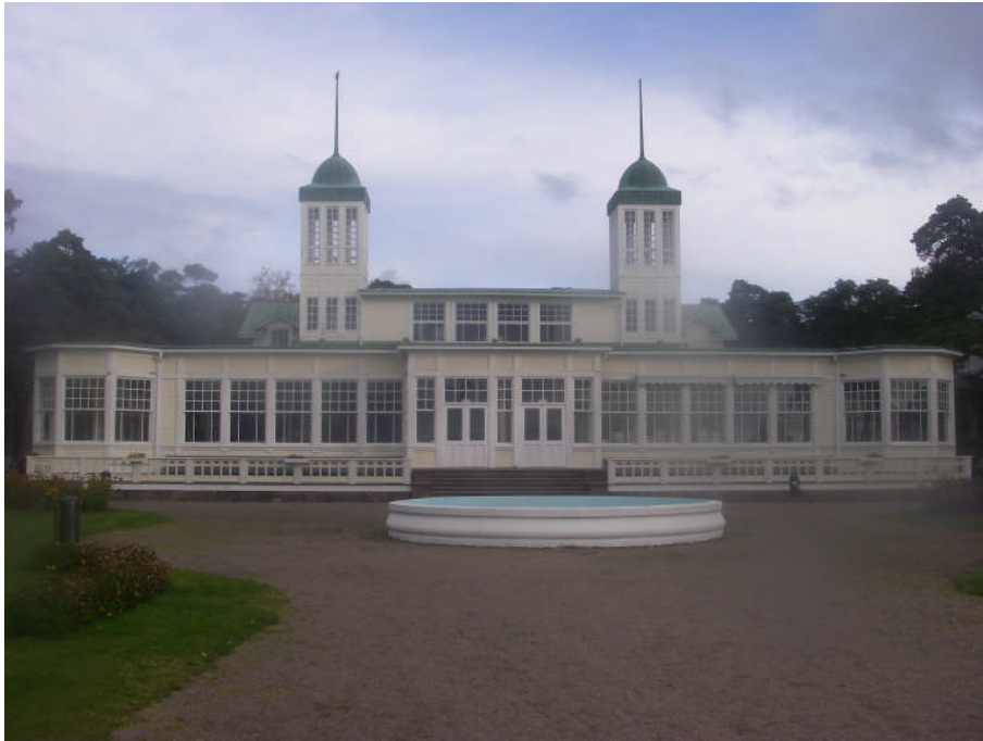
Tarkastetun rakennuksen eteläpuolen julkisivua
