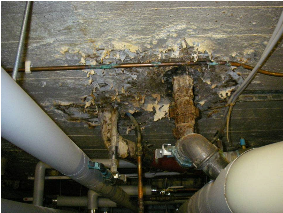
Pannuhuoneessa on vanhoihin rakenteissa oleviin putkiin yhdistetty uutta materiaalia.
