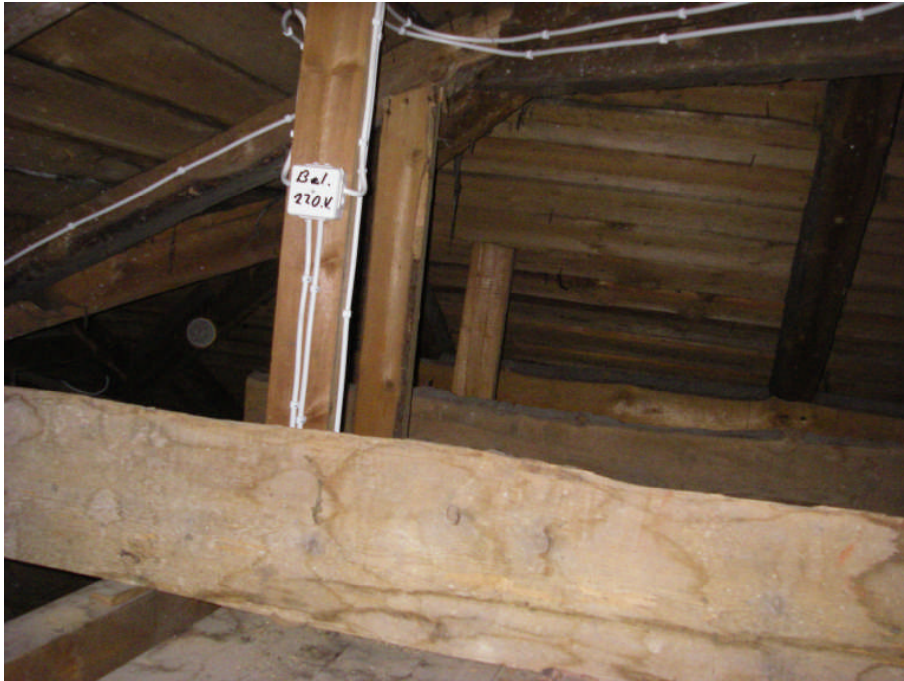
Kattorakenteissa ei nähdyllä osin havaittu korjausta vaativia vaurioita
