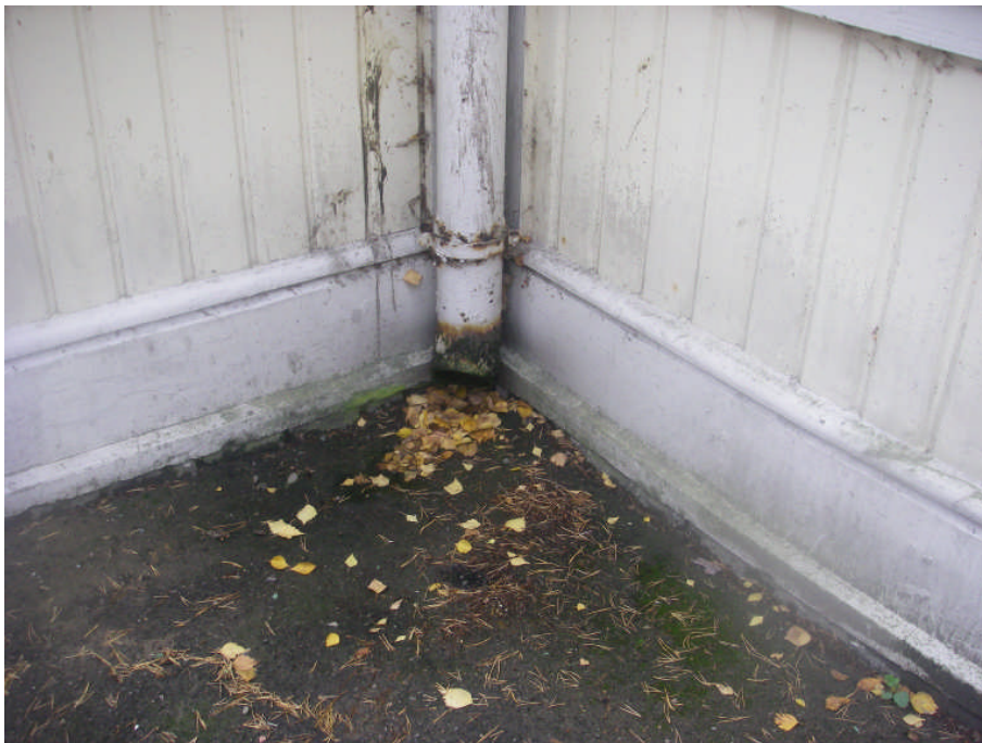
Syöksytorvien alla ei ole erillistä vesien poisjohtamisjärjestelmää
