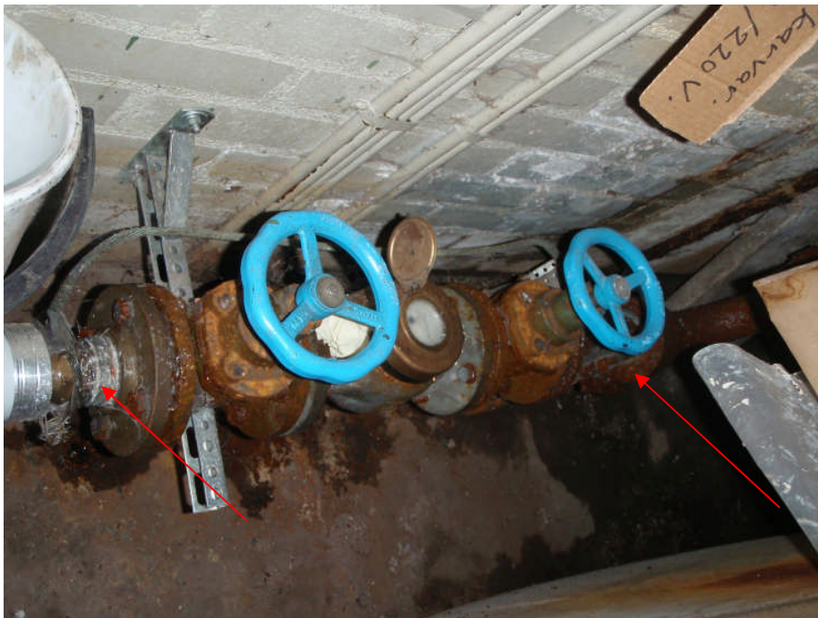
Putkistomaadoituksia. Käyttövesimittarin yliheitto.
