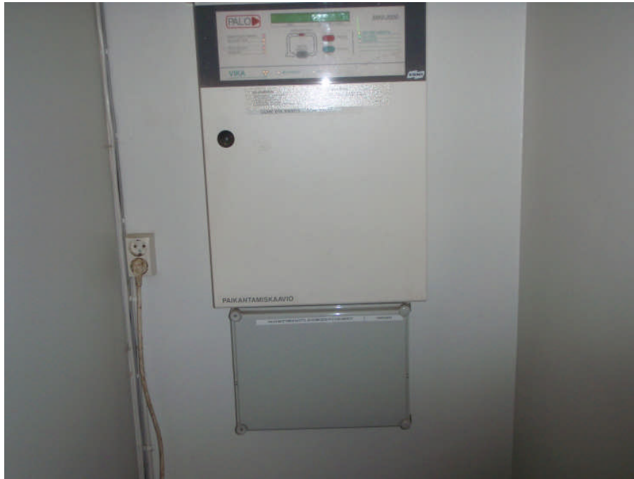
Paloilmoitinjärjestelmän keskus. Esmi Mini 2000.
