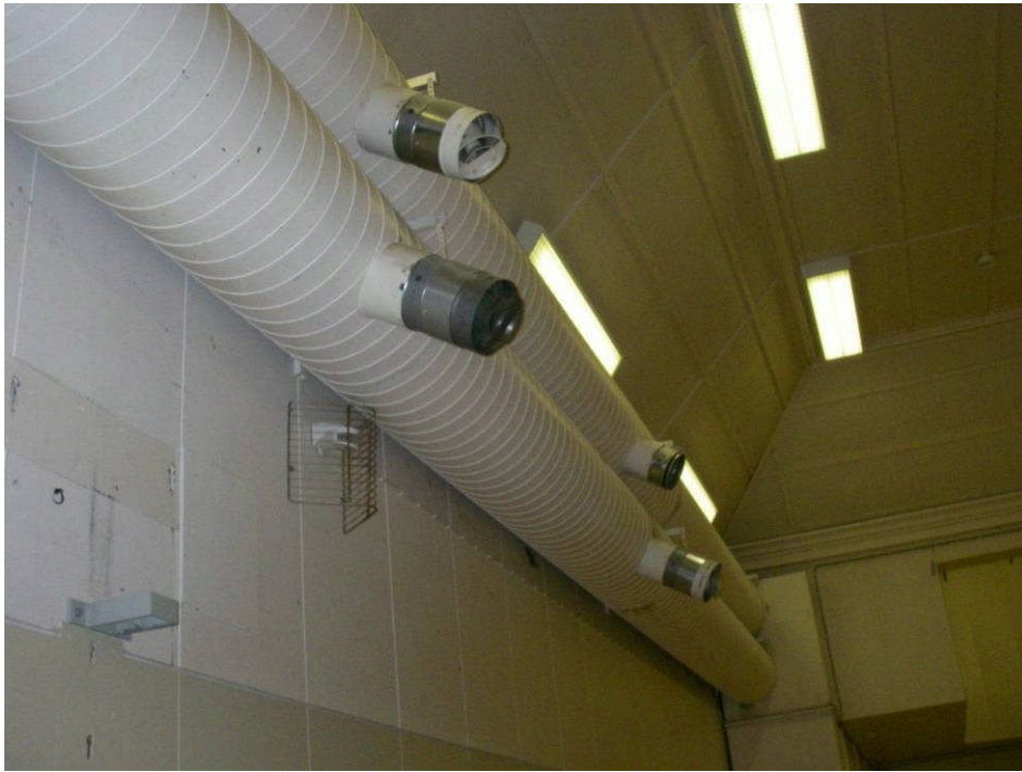
Jumppasalin ilmanvaihtokanavia.
