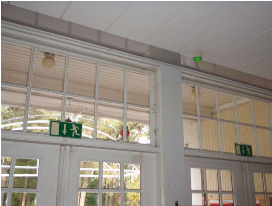
Turvavalaistusjärjestelmän opastevalaisimet ovat opasteettomia hehkulamppuvalaisimia.
