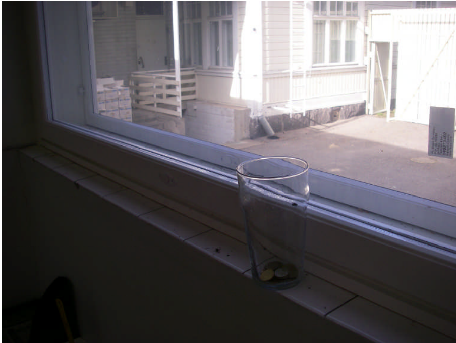
Keittiön ikkunat ovat uudehkoja ja ne eivät vaadi toimenpiteitä
