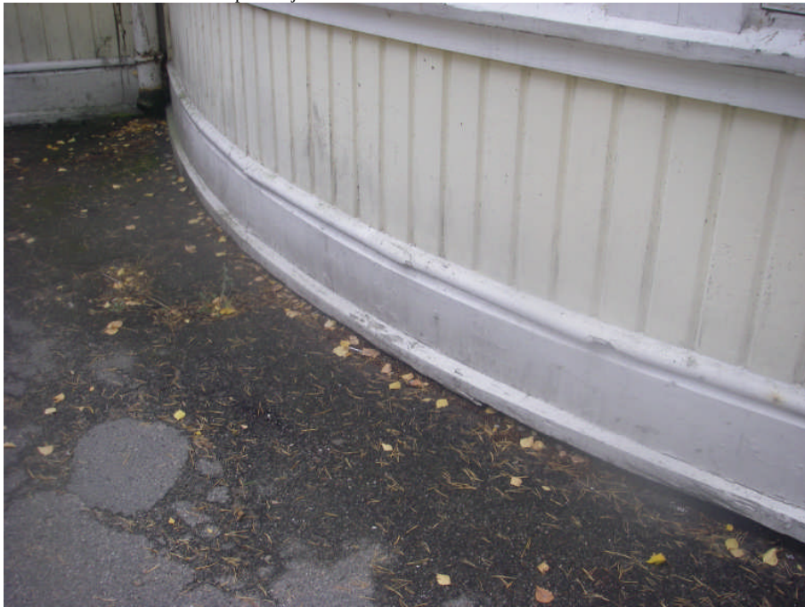
Kävelytien puolella puurakenteet lähtevät maanpinnalta
