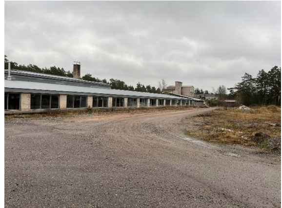
Kuva 5. Olemassa oleva tiilirunkoinen rakennus.
