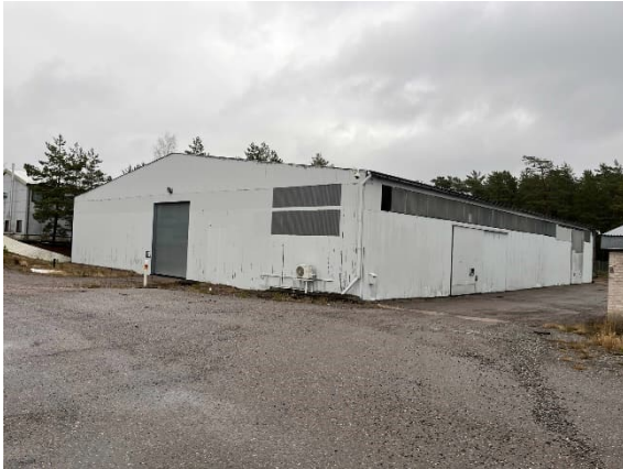
Kuva 4. Olemassa oleva teräsrunkoinen halli.
