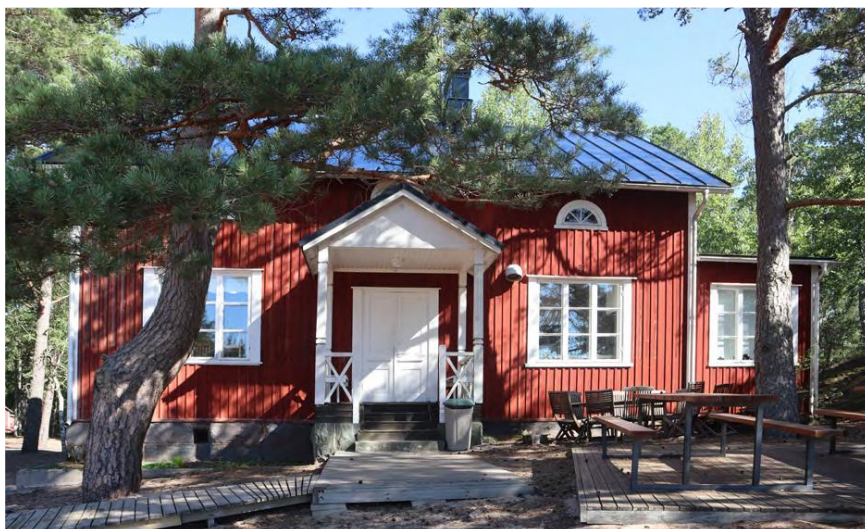
4. Kök och matsalsbyggnad (1929)
