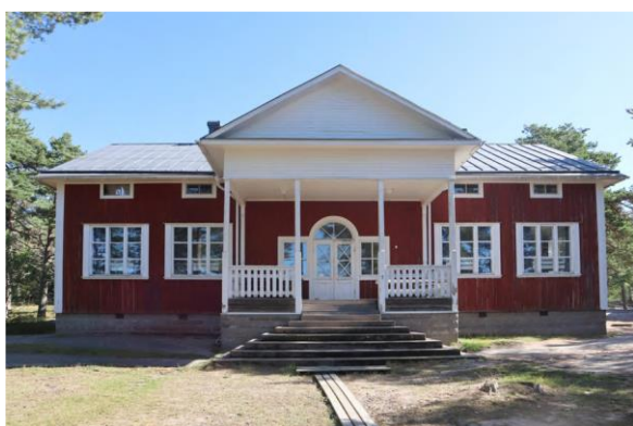
2. Nya Villan, inkvarteringsbyggnaden (1939)
