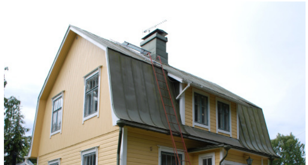
Bild 13. Exempel på takformer. Sadel- och valmat tak.
