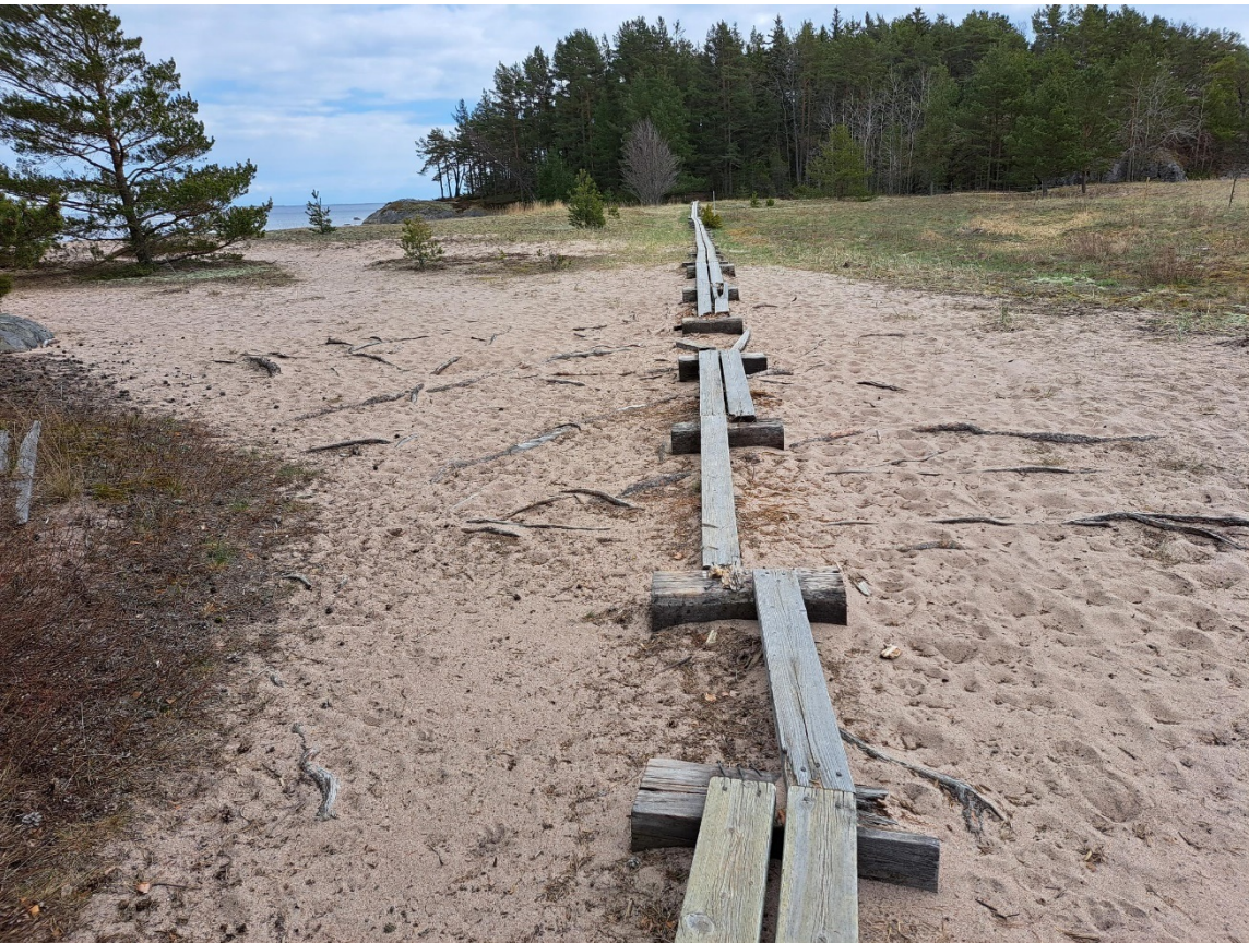
Kuva 4. Pitkospuut 150m, uusittava osuus n. 15 m
